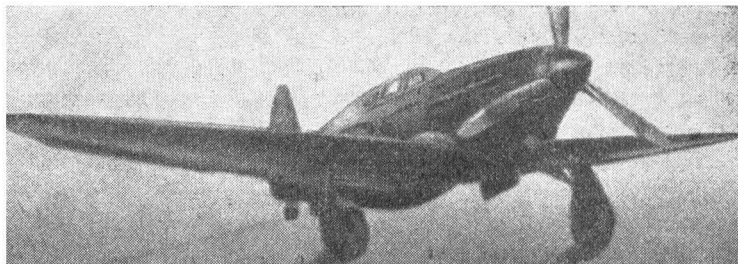
Dvosedežno lovsko letalo (Jak 7), ki ga žene motor s storilnostjo 1200 KS. Z razpetino kril 10 m je med najmanjšimi lovskeimi letali na svetu. Oboroženo je z dvema strojnicama in enim topom. Letalo leti s hitrostjo 720 km/h.
